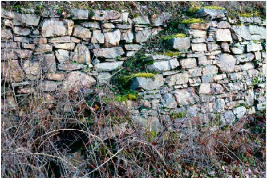
Abbildung 5: Weinbergsmauer, Trockenmauer, aus Quarzitbruchstein.
