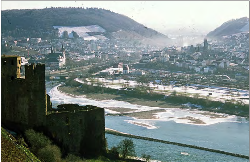
Abbildung 6: Für mehr Fahrwassertiefe in der Fahrrinne erweiterter Nahegrund vor Bingerbrück, davor die „Binger Mauer“ (KÜMMERLE 2022); Foto: E. Kümmerle.
