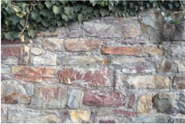
Mauerwerk in den Weinbergsterrassen bei Rüdesheim (Photo: HLUG).
