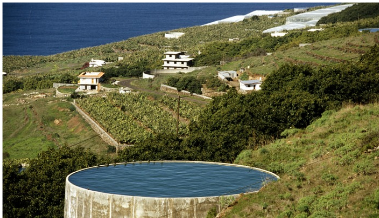
Regenwasserbecken werden zu wenig genutzt; Foto: WDR/ Paul Eckenroth.
