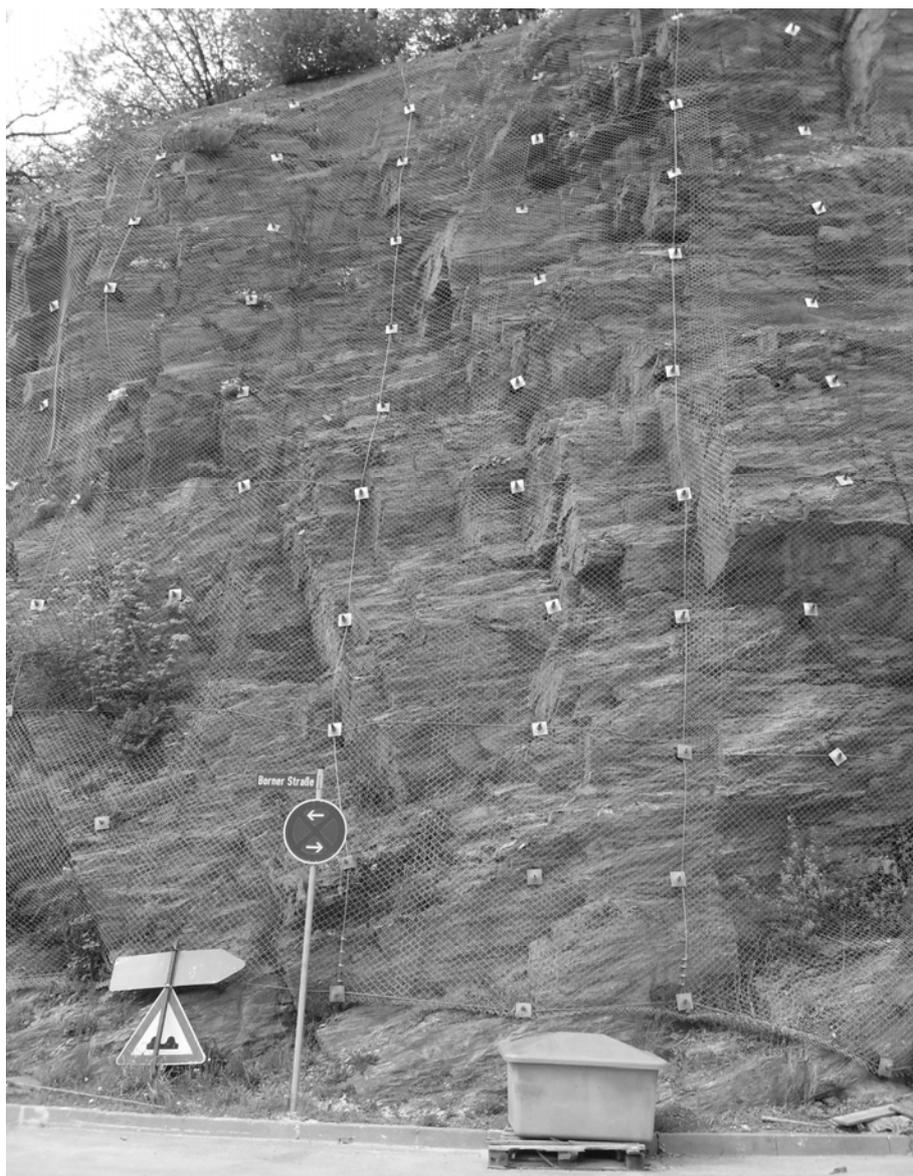
Verankerte Stahlnetze überspannen die Felswand an der B 54 in Adorfseck – hier ist die Sicherungsmaßnahme zumindest teilweise notwendig (Foto: Toussaint).
