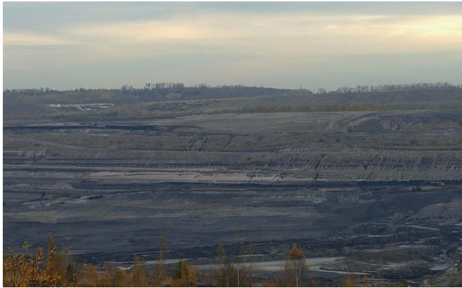
Rekultivierung eines Tagebaus bei Schöningen. Im Hintergrund der spätere See, vorne setzt bereits die Bodenbildung auf dem Kippenboden ein; Foto: Gunnar Ries.
