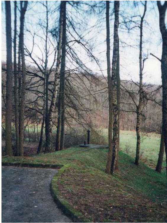
Abb. 9 Alte Fassung von Rambach am Wengenrod- Stollen (1902).
