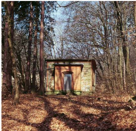
Abb. 7 Portal des Münzbergstollens (1875–1888).
