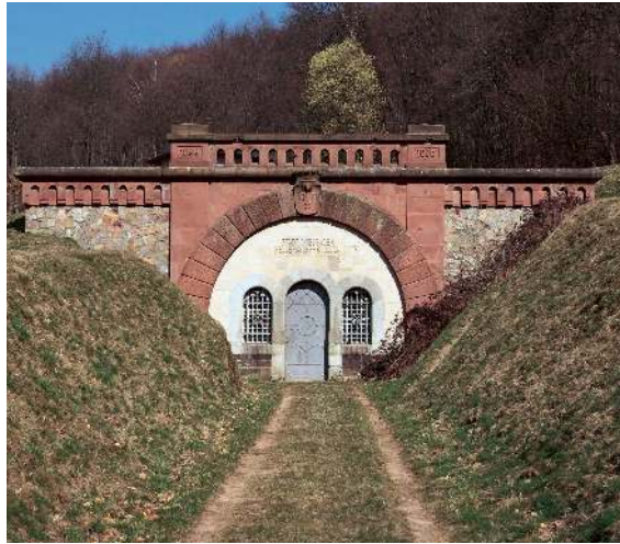
Abb. 5 Portal des Kellerkopfstollens im oberen Rambachtal (1899–1906).
