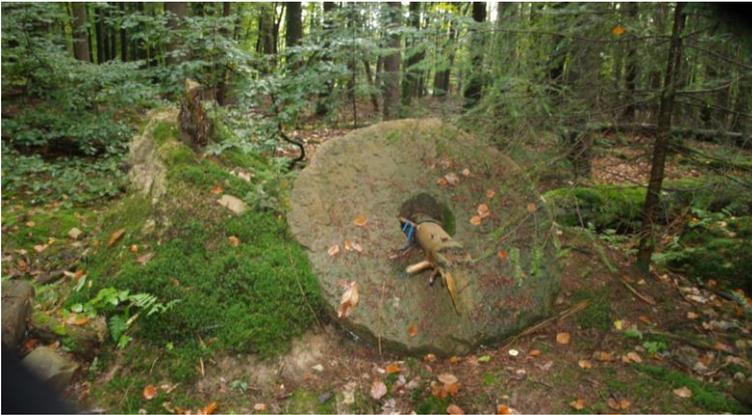
Abbildung 10: Mühlsteinförmige 400 kg schwere Abdeckung aus Sandstein auf einem vermuteten Kaskadenschacht; Foto: Verfasser.
