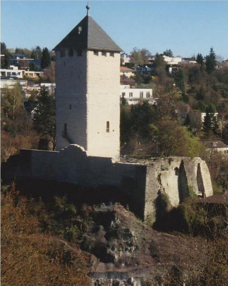
Abbildung 1: Burg Sonnenberg, überwiegend aus bodenständigem Serizitgneis (Meta-Rhyolith).
