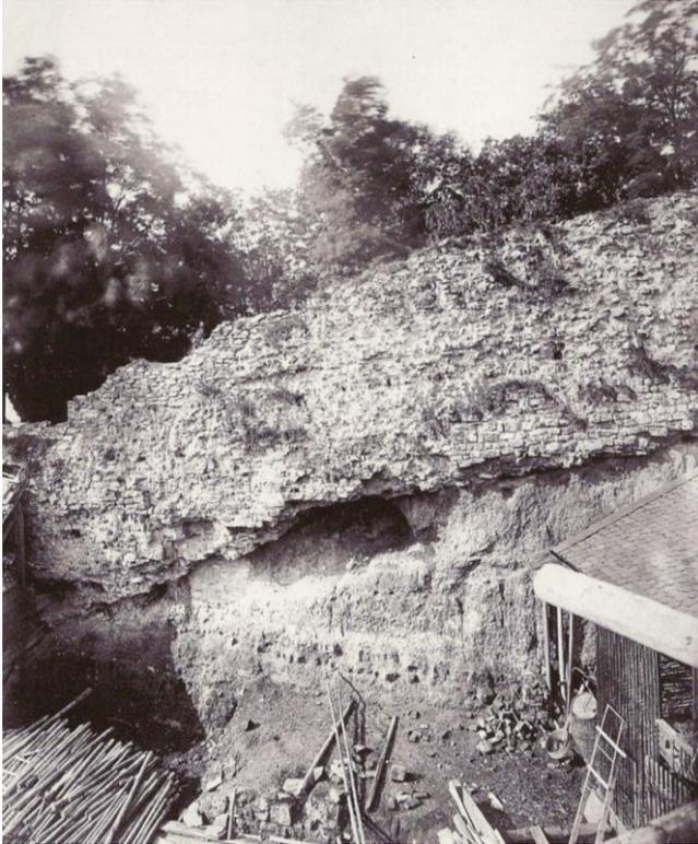
Abbildung 6: Freilegung der Heidenmauer im Jahr 1902 im Zuge des Durchbruchs der neuen Coulinstraße und des Baus des Römertores. Nach dem mittelalterlichen und späteren Raub der Verblendung aus graugrünem Serizitgneis Blick auf das massive Bauwerk aus römischem „Beton“ (opus caementicium) und unter der Heidenmauer erkennbare ältere Bauwerks-Konstruktionen; Foto aus hist. Dokumentation E. RITTERLING 1909.
