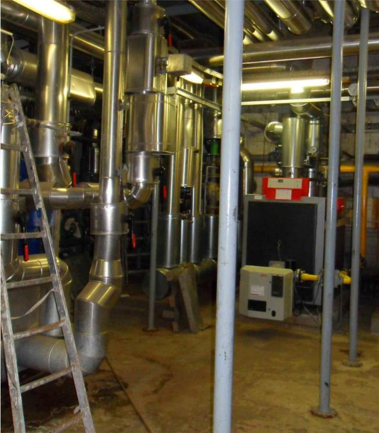
Abbildung 6: Thermalwasseraufbereitung und -weiterleitung im Keller der Kaiser Friedrich-Therme; Foto: Verfasser.
