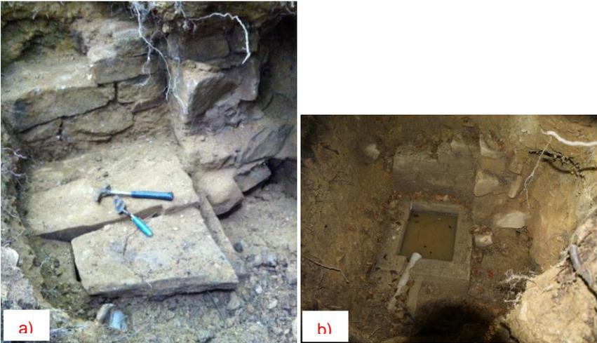
Abbildung 12: a) Abgedecktes bzw. b) offenes Auffangbecken aus Sandstein mit Abflussrohr, eingebaut zwischen Naturstein-Stützmauern aus Serizitgneis zur Trassensicherung der Nassauischen Leitung gegen quer verlaufenden Kanal, vermutlich römisch; Foto: Verfasser.
