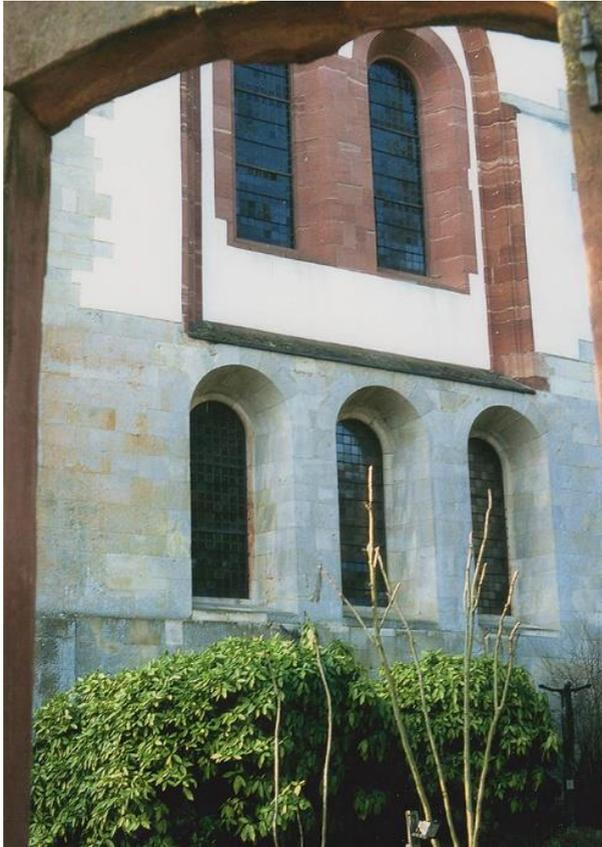
Abbildung 10: Ostfront Klosterkirche Eberbach. Quader aus Tertiärkalkstein, Fensterleibungen aus rotem Mainsandstein.
