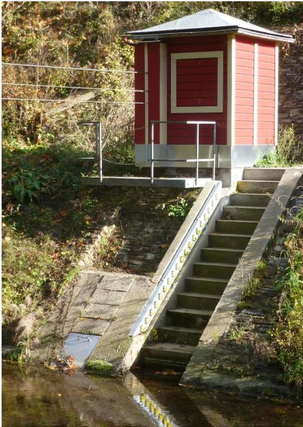
Abbildung 4: Pegel Lorch-Pfaffental (Messstellenummer: 25650156; Gauß-Krüger-Koordinaten: R 341760, H 554686; Pegelnullpunkt: 102,04 m ü. NN; Lage: 4,5 km links oberhalb der Mündung der Wisper in den Rhein; Fläche oberirdisches Einzugsgebiet: 170,40 km<sup>2</sup>).
