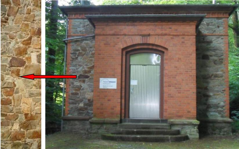
Abbildung 11: Portal des Münzbergstollens mit vermauertem Taunusquarzit. Die bräunlichen Farben gehen auf die Ausfällung Fe-reicher Lösungen auf Kluftflächen zurück; Foto: Toussaint.
